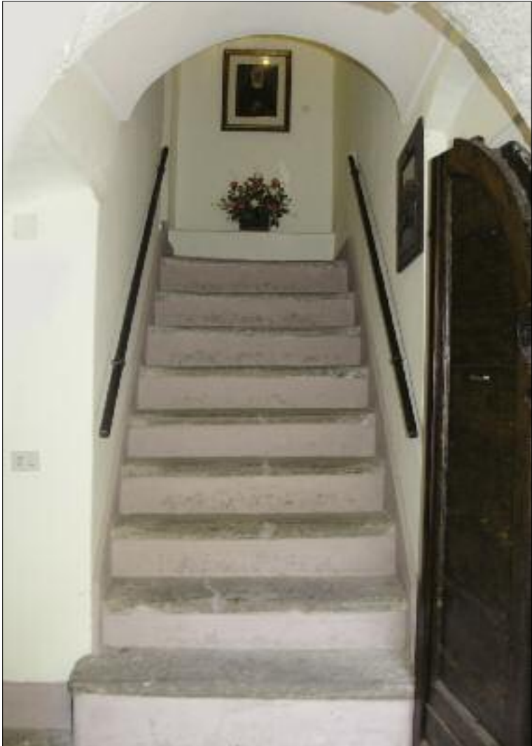
Scala di ingresso. Con il gradino iniziale a sinistra (non visibile) e i due (ugualmente non visibili) nella svolta a sinistra sono dodici come dalla perizia del 1813.
